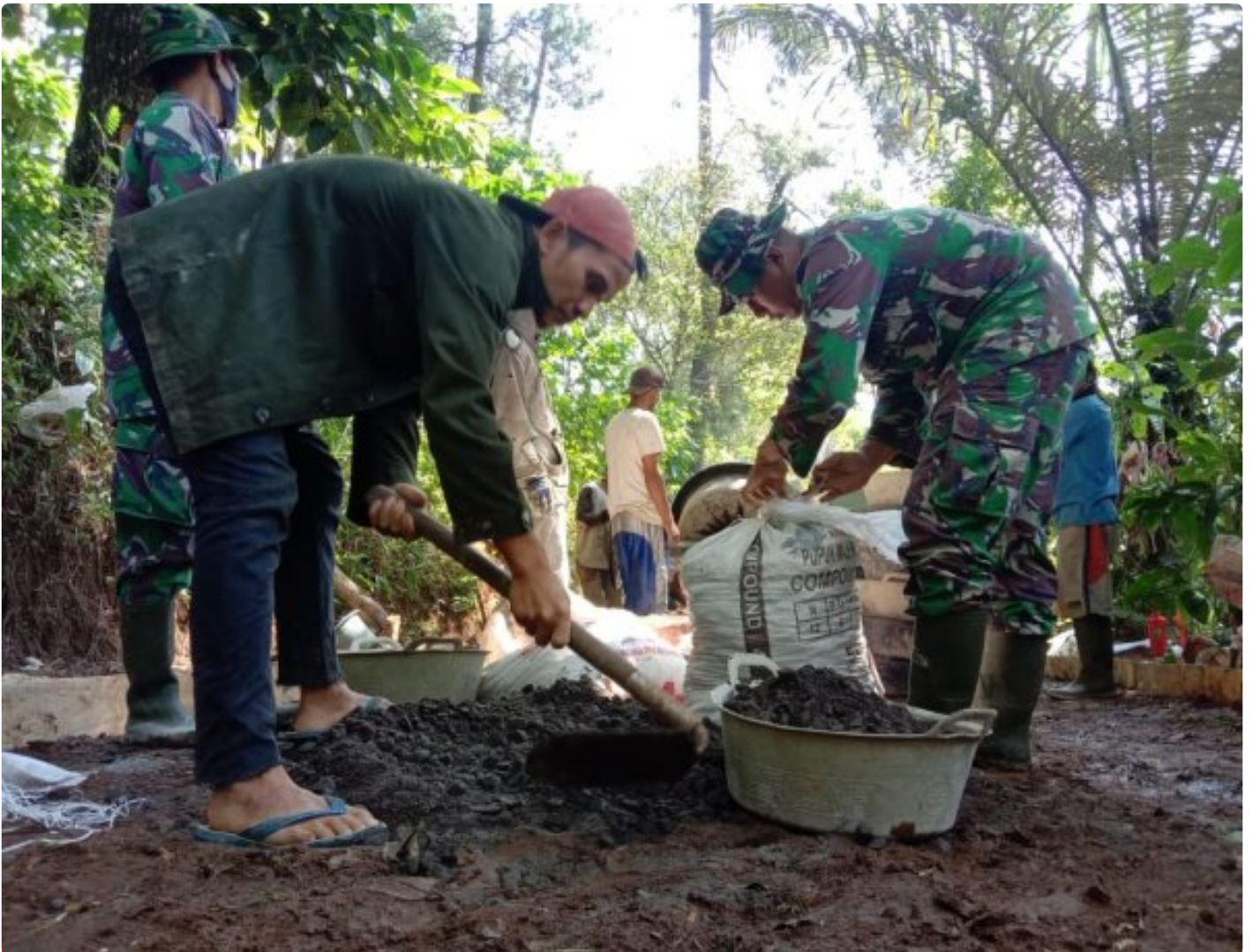
Satgas TMMD dan Warga Bahu Membahu Kebut Pengecoran Jalan
